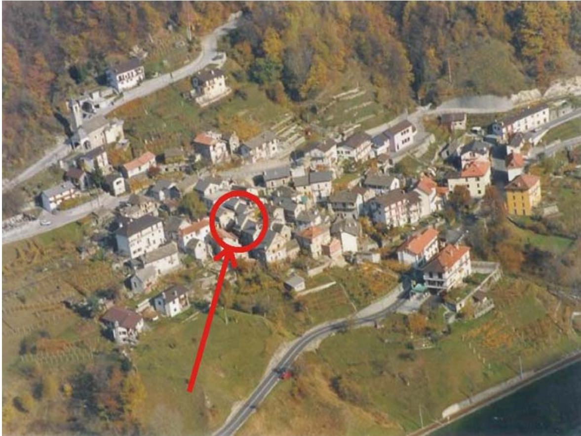
Oben – Luftbild von Camedo mit Kennzeichnung des Objektes
